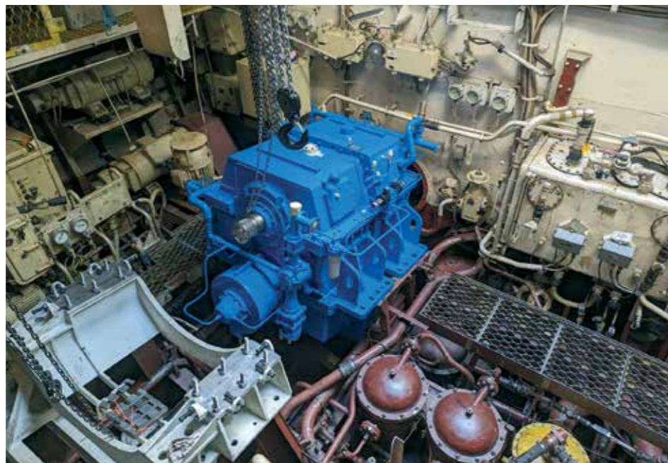
REDUCTORUL INVERSOR 3600 în curs de montaj pe navă
